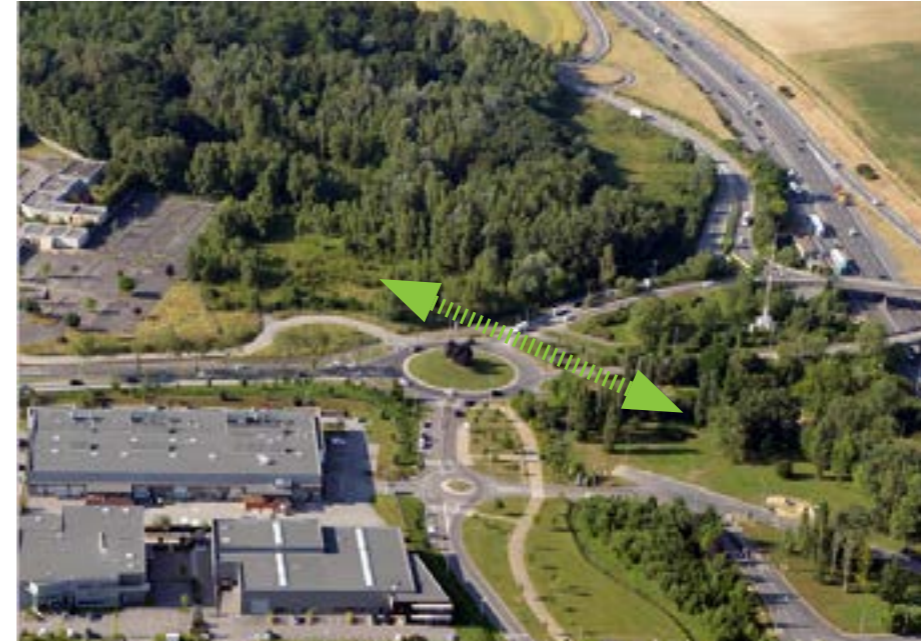
Exemple : point obstacle n°67_4 entre les UEP du Plateau du Franc-Lyonnais – Sud et l'Île de Miribel-Jonage, commune de Rillieux-la-Pape
