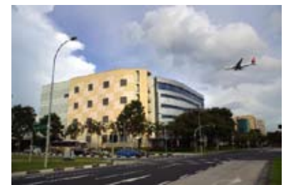
Des bâtiments logistiques et de bureaux sur plusieurs étages (Singapour)
