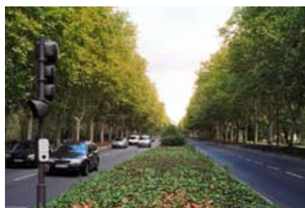
Une 2x2 voies peut être un boulevard urbain : Laurent Bonnevay entre le parc de la Feyssine et la Doua
