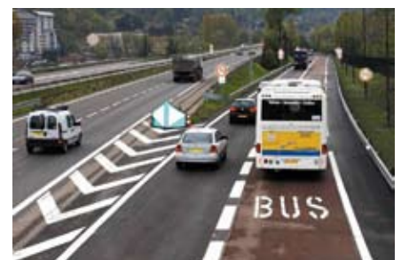
Une « autoroute apaisée » mise en œuvre à Grenoble : voie de bus et réduction de la vitesse
