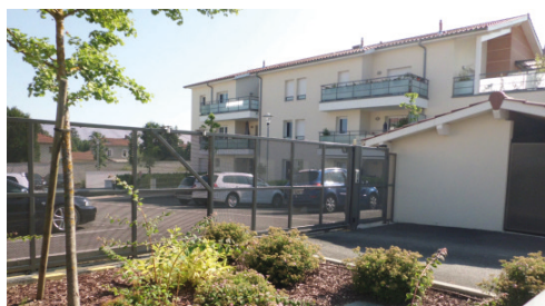
Logements collectifs privés (Atelier Densité, 2015)
