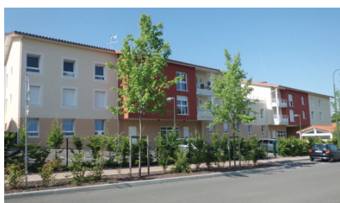
Logements sociaux (Atelier Densité, 2015)
