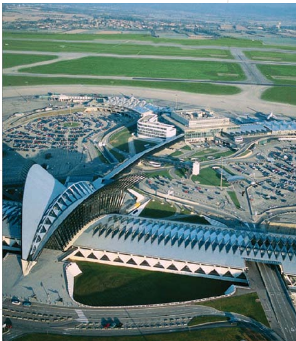
Site de l'aéroport de Saint-Exupéry
