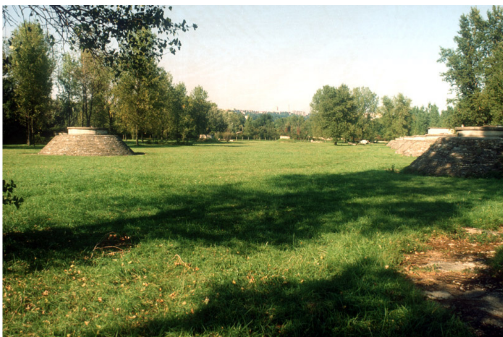
Puits de captage à la Feysine
