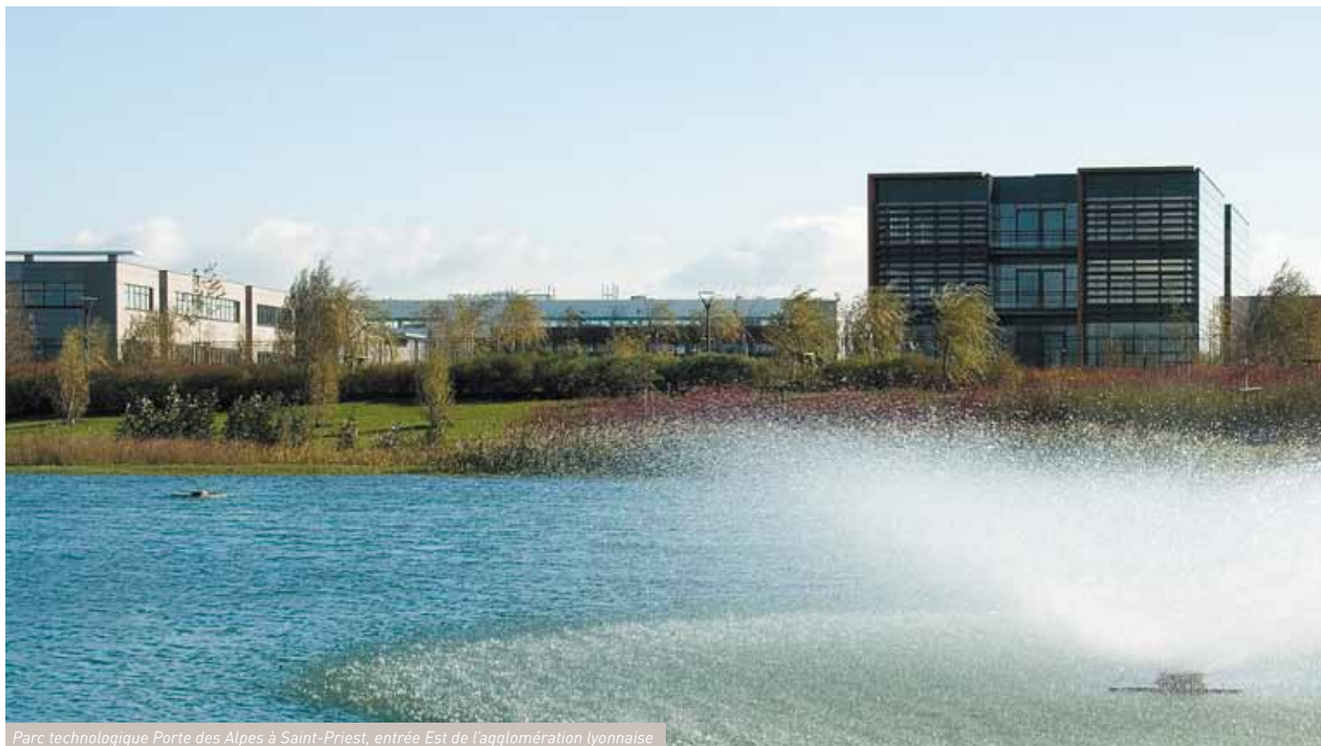
Parc technologique Porte des Alpes à Saint-Priest, entrée Est de l'agglomération lyonnaise
