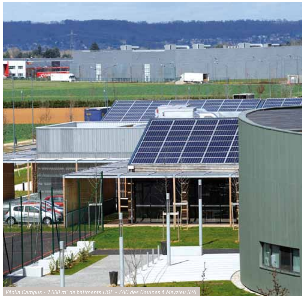
Véolia Campus - 9 000 m 2 de bâtiments HQE - ZAC des Gaulnes à Meyzieu [69]
